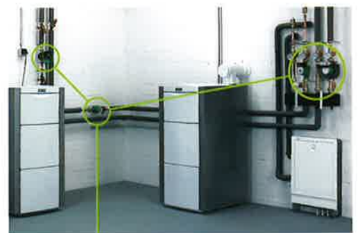
Typische Einbau-Positionen für die Hocheffizienzpumpe
